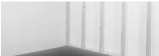
Subestructura de madera
