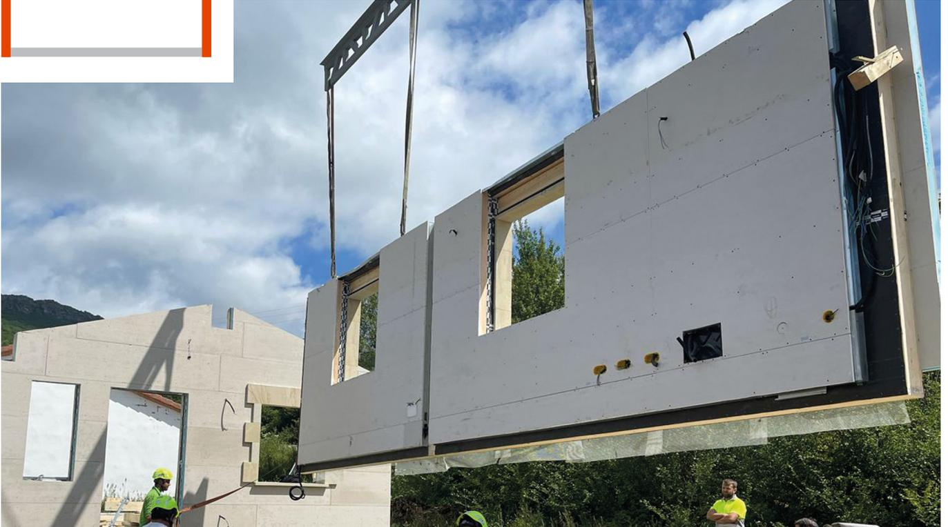
Compuesto de panel exterior TFbcY de núcleo aislante variable, panel interior TYY de núcleo variable y placa de cartón-yeso RF al interior. Disposición de montantes cada 80cm. Acabado exterior libre.
