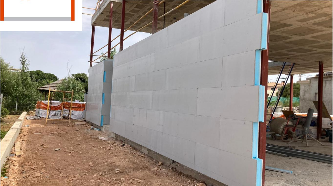
Compuesto de panel exterior TFbcY de núcleo aislante variable y trasdosado interior COAT de doble placa. Disposición de montantes cada 60cm. Acabado exterior libre.
