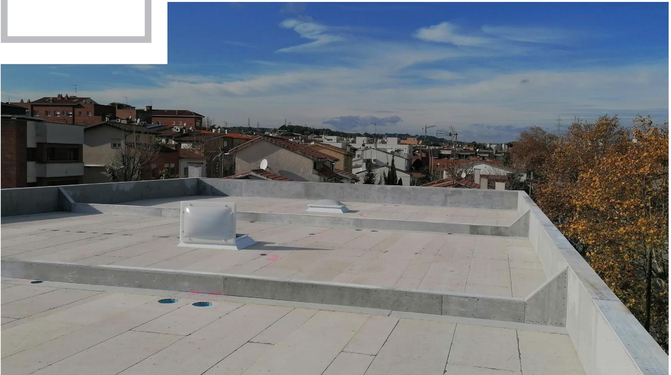
Compuesto de panel exterior TFbcY de núcleo aislante variable y falso techo interior COAT de doble placa. Disposición de apoyos cada 60cm en cubierta transitable y cada 120cm en no transitable. Acabado exterior libre.
