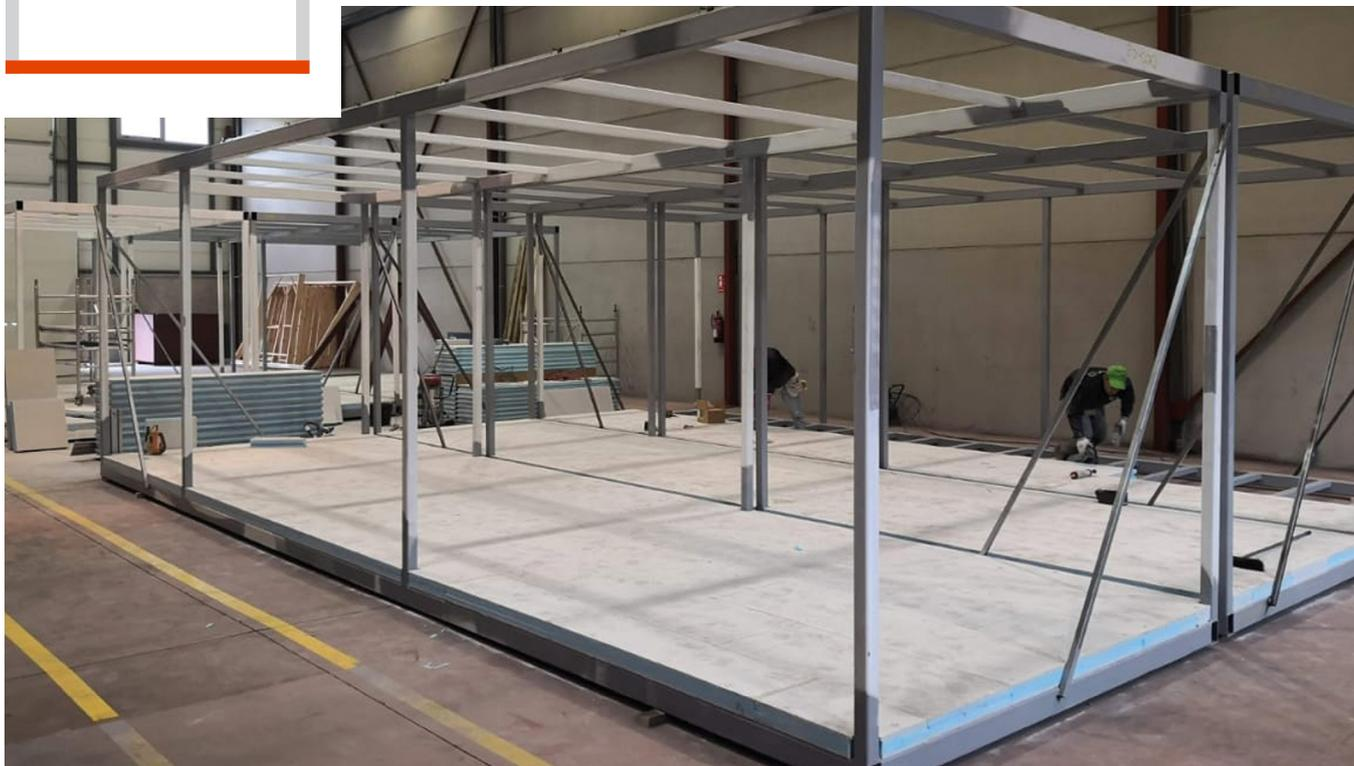
Compuesto por panel exterior TFbcY de núcleo aislante variable y solera seca sobre panel. Disposición de apoyos cada 60cm. Acabado libre.
